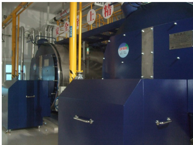
将原有燃油锅炉更新为燃气锅炉，减少对大气的污染。
