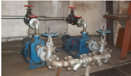
生产车间泵水场地加装循环水使用装置，大大降低水资源的浪费。
