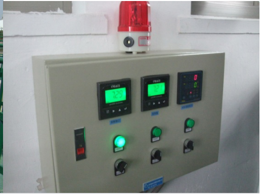
雨水泵站一角雨水泵站 PH 值在线监测仪
