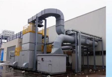
普利司通无锡工厂废气净化装置的活性炭交换吸附塔
