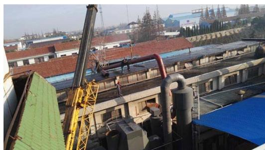
二是针对目前浸塑车间配方面吸尘环保除尘系统，通风除尘系统效果不理想，原使用的吸尘器靠自然拔风，存在排放量小、吸尘效果差的不足。现将自动拔风改为用电动吸尘器引风，促使排放量流畅高效，减少物料泄露飞扬。通过整改达到减少粉尘吸入的效果，提高了环境质量保障了操作员工的身体健康，使她们能在操作过程中放心，在本职岗位上积极工作。
